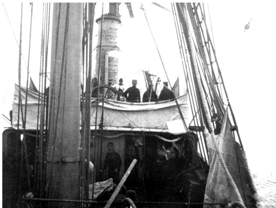
Guardia en el Puente de Comando, abierto con cenefas colocadas
