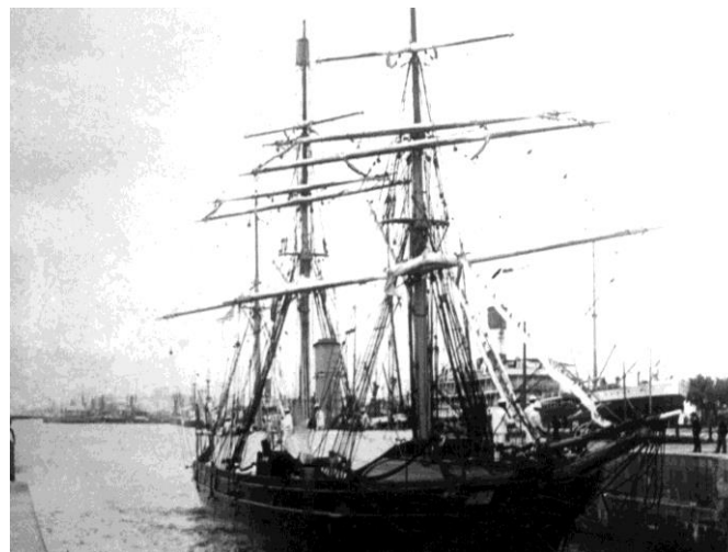
Maniobra de entrada a dique de carena
